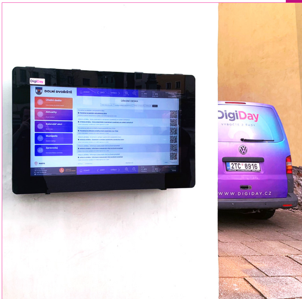
Foto: Instalace v Dolním Dvořišti / Duben 2023
